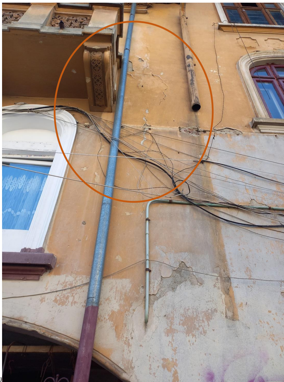
Figura 10 – Fisuri pereți de zidărie (fațada de nord-est)
