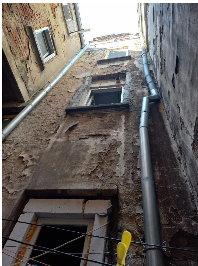
Figura 11 – Degradări tencuială pereți de zidărie înspre curtea interioară
