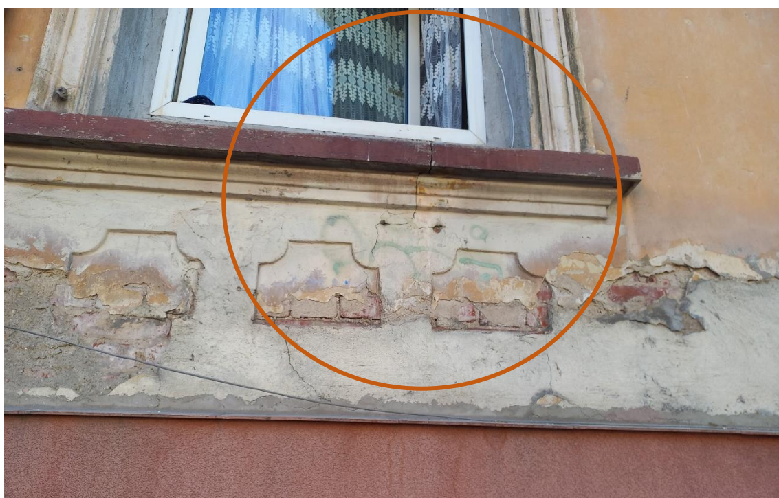
Figura 9 – Degradări fațada de sud-est
