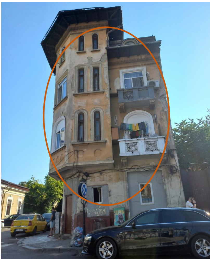
Figura 8 – Degradări fațada de sud-vest
