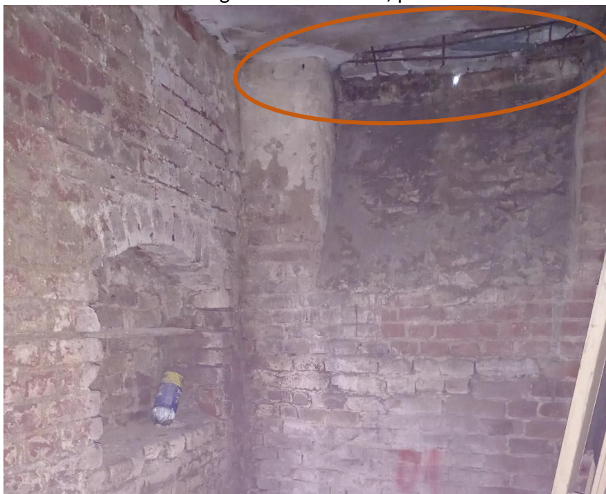
Figura 12 – Planșeu peste subsol cu stratul de acoperire expulzat și bare de armătură corodate
