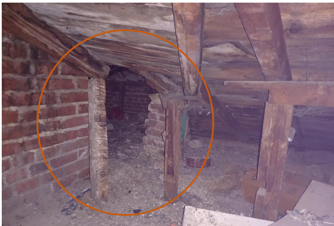
Figura 13 – Degradări popi șarpantă de lemn
